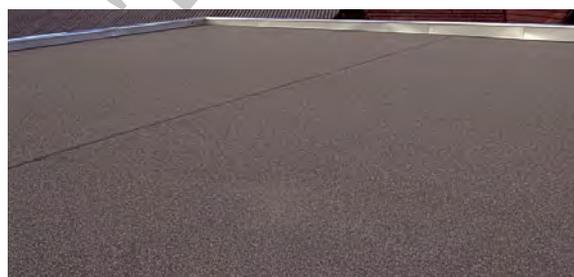
Fig. 3/501: Etanchéité en asphalte coulé; revêtement saupoudré
