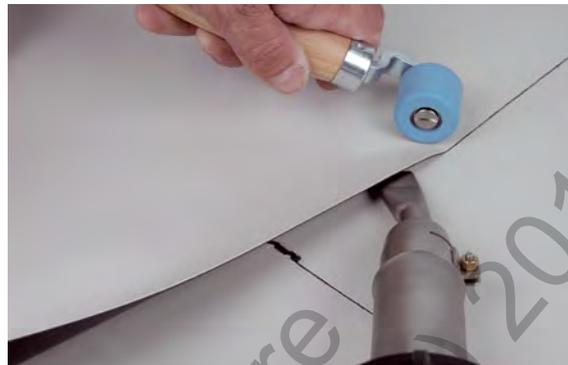
Fig. 4/103: Soudage avec buse 20 mm
