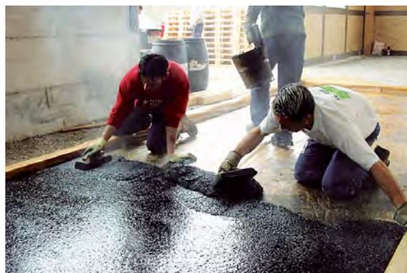
Fig. 3/505: Revêtement intérieur praticable en asphalte coulé; étalement de l'asphalte
