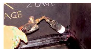
Fig. 3/307: Renforcement des angles; souder les renforts au chalumeau
