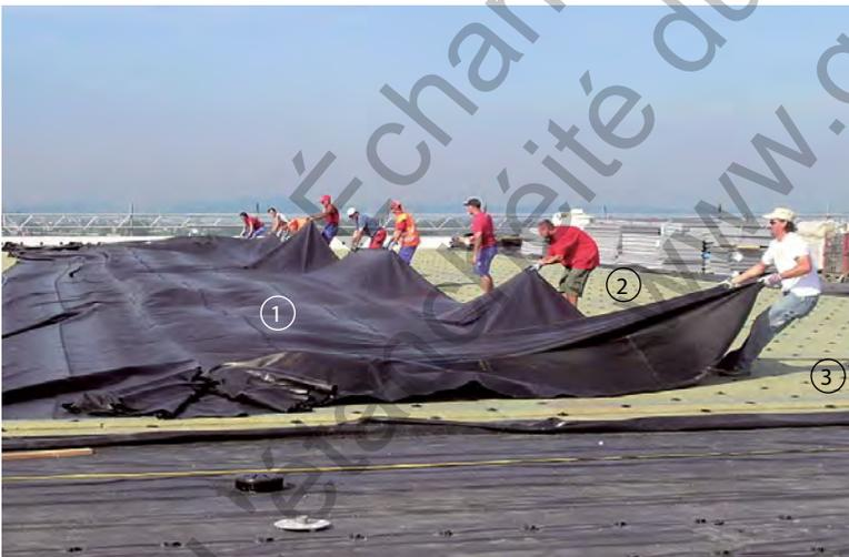
Fig. 2/720 : Étanchéité avec des lés en EPDM, déploiement de la membrane d'étanchéité préconfectionnée (1) sur l'isolation thermique posée (2).
