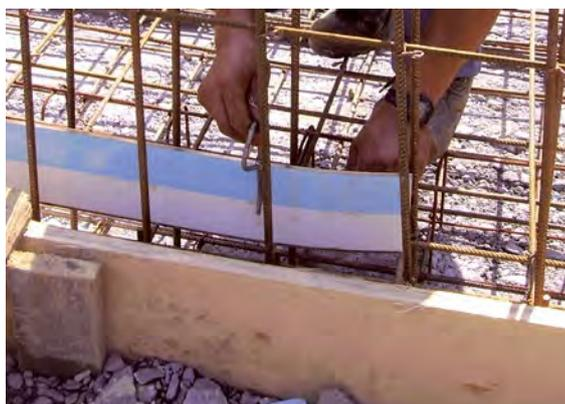
Fig. 2/222: Tôle de joint, montage
