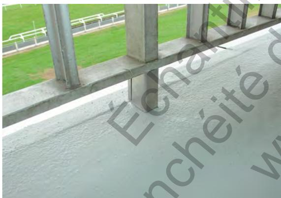
Fig. 2/714: Étanchéité en polymère liquide (EPL); raccordement aux poteaux
