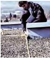
Fig. 2/718 : Étanchéité avec des lés en EPDM, prise de mesures sur le site
