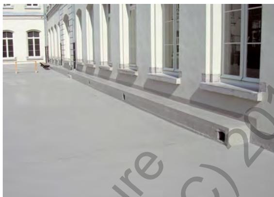
Fig. 2/715: Étanchéité en polymère liquide (EPL)
