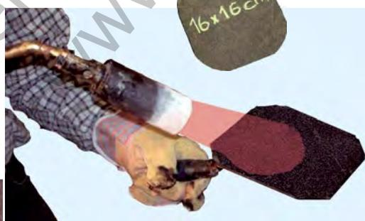
Fig. 3/308: Renforcement des angles; bien presser la pièce de renfort en évitant tout vide d'air
