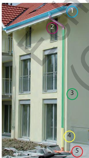
Fig. 3/701: Récupération des eaux de toiture; Chéneau (1), Col de cygne (2), Tuyau de descente (3), Dauphin (4), Canalisation (5)
