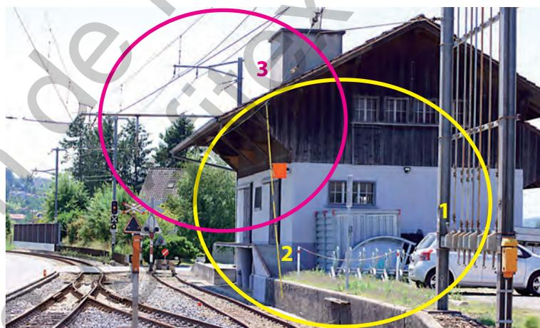
Fig. 2/906: Avant de travailler dans la zone de la ligne (3), les caténaires doivent être mises hors tension (1) et reliées à la terre (2) par le personnel des chemins de fer
