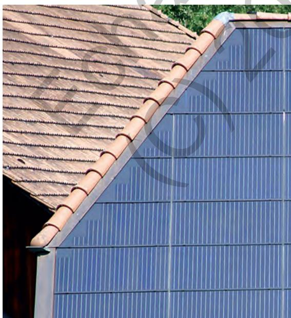
Fig. 3/1007 : Panneaux solaires comme couverture ; raccord aux arrêtes
