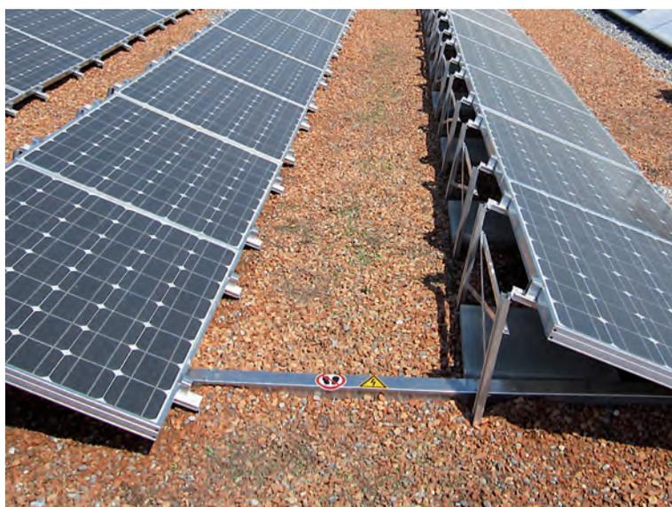
Fig. 3/1010 : Panneaux solaires sur un toit plat ; montage sur supports
