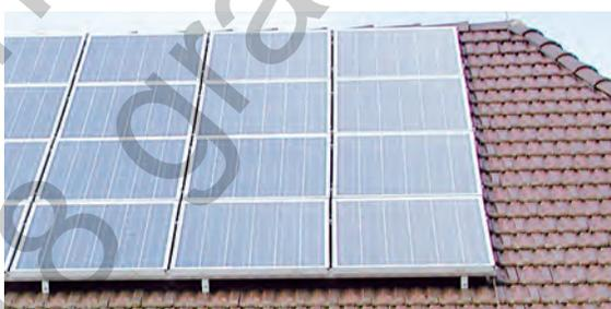
Fig. 3/1009 : Panneaux solaires montés sur la toiture (montage sur supports)
