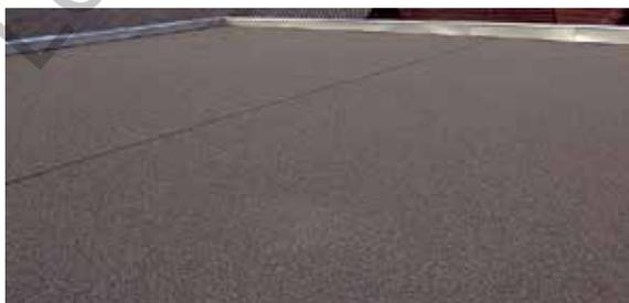
Abb. 3/501: Gussasphalt-Abdichtung; Belag abgestreut
