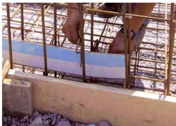
Abb. 2/222: Fugenblech; Montage
