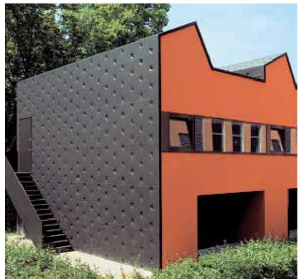
Abb. 2/721: Abdichtung mit EPDM-Bahnen;
