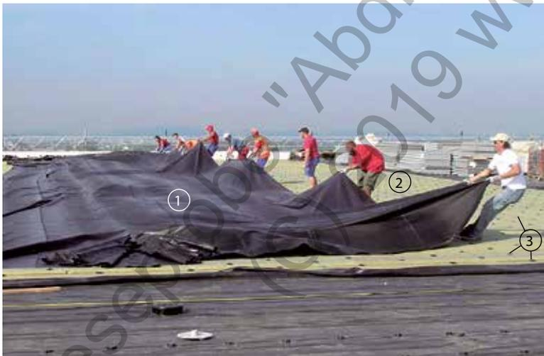
Abb. 2/720: Abdichtung mit EPDM-Bahnen; Entfalten der vorkonfektionierten Abdichtung (1) auf der fertig eingebrachten Wärmedämmung (2).
