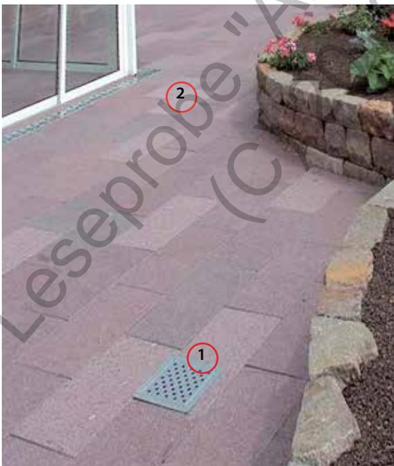
Abb. 5/214: Entwässerung einer Terasse; Regenwassereinflauf (1), Entwässerungsrinnen (2)
