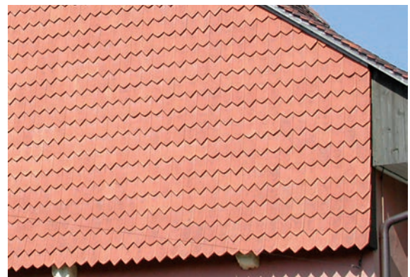
Abb. 3/415: Dachziegel als Wandbekleidung
