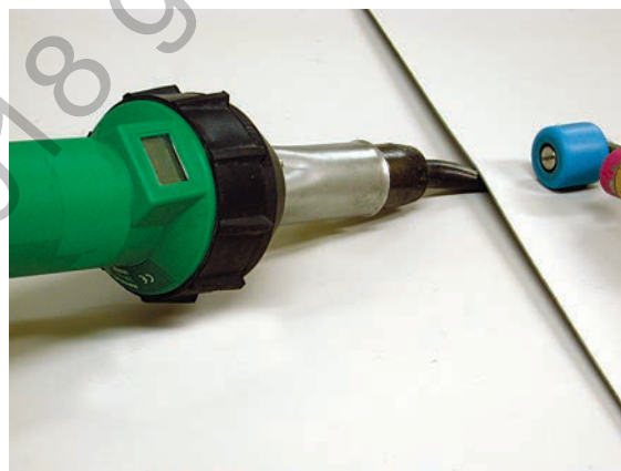
Abb. 4/1002: Kunststoff-Dichtungsbahnen verschweißen
