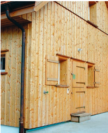
Abb. 3/413: Aussenwand mit Holzschalung
