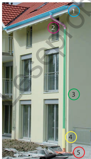
Abb. 3/701: Dachentwässerung; Dachrinne (1), Schwanenhals (2), Fallrohr (3), Sockelrohr (4), Grundleitung (5)
