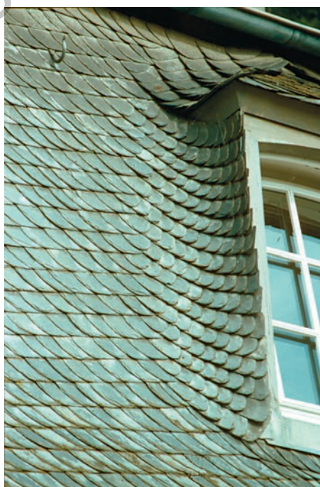
Abb. 3/146: Schieferdeckung (Altdeutsche Deckung)
