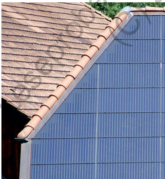
Abb. 3/1007: Solarmodule als Deckung; Gratanschluss
